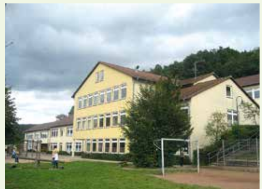
Geisbergsschule – Grundschule Eidengesäß
